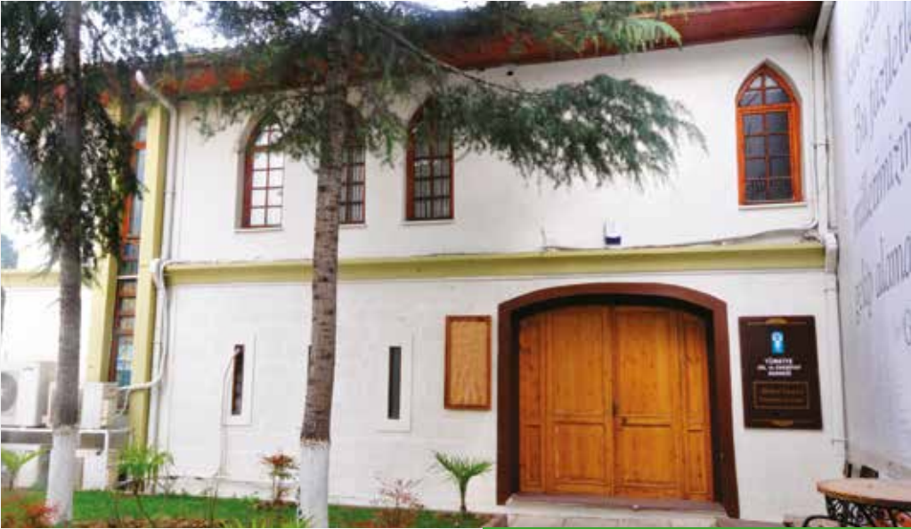
Ahmet Yesevî Hizmet Binası
